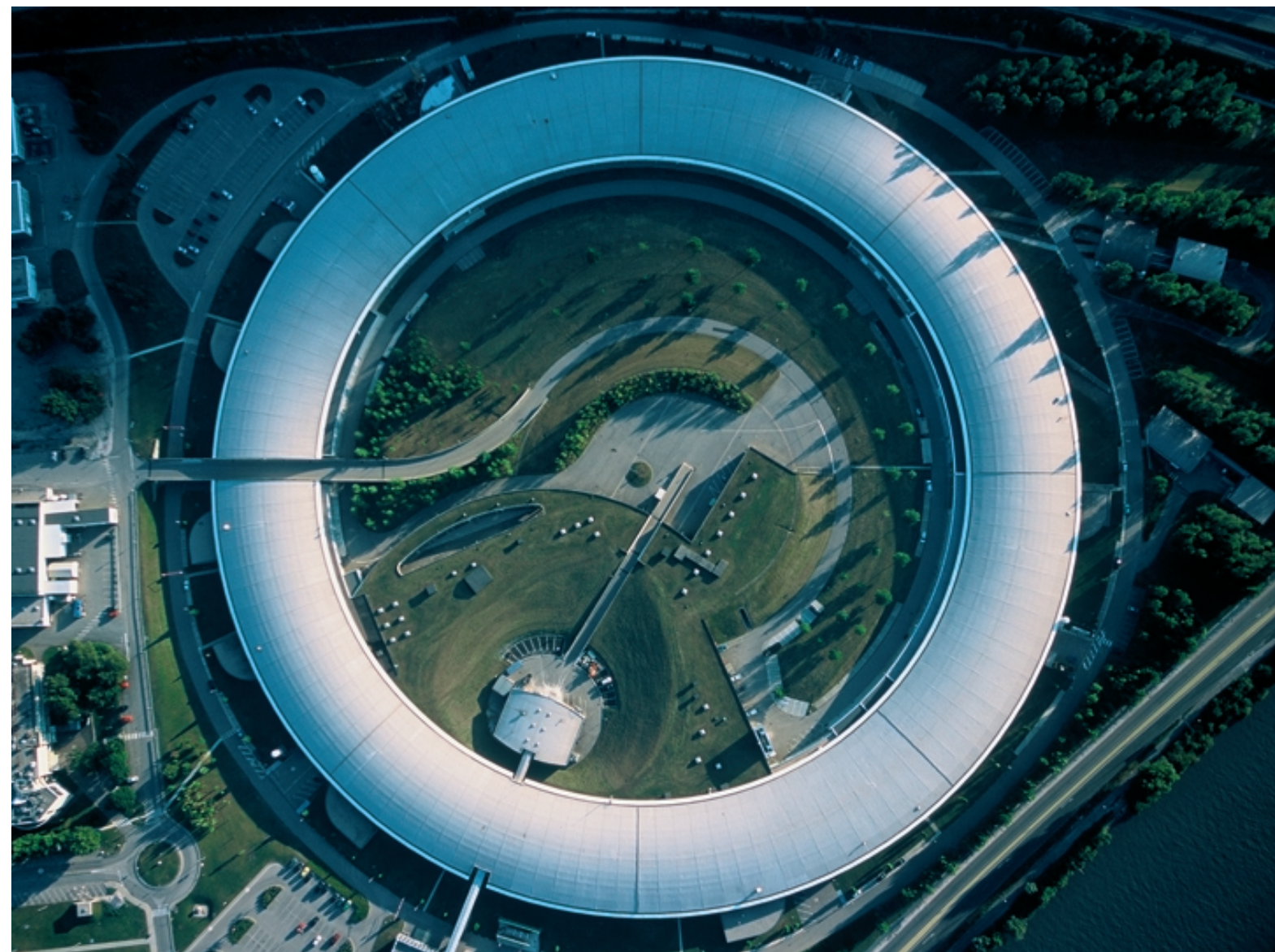
Foto boven: Het centrale element van het gebouw is de opslagring van 844 meter lang.
